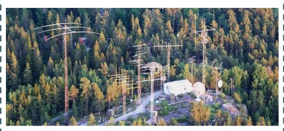
Algunas de las antenas de SK0UX, la 3 el de la izquierda es para 80 y 75 metros, a 45 metros de altura. No se ven en la foto otras grandes antenas monobanda, como la cúbica de 6 el para 20 metros y la cúbica 2 el para 40 metros. La parábola a la derecha es de 6 m de diámetro y se usa para Rebote Lunar.
